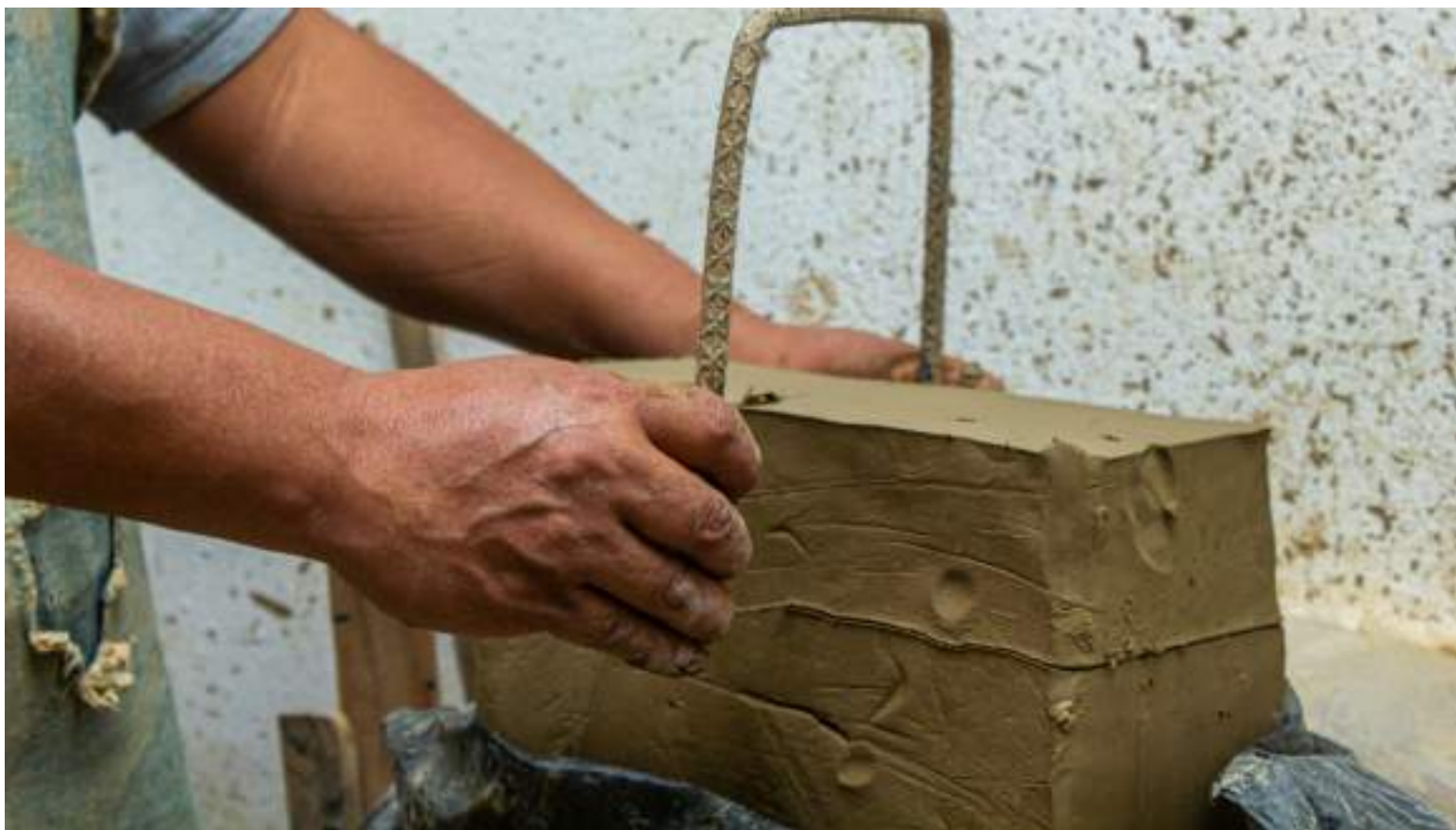
▲ PROCESO DE CORTADO DE BARRO. Fotografía: Ángel Juárez Diego.
